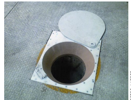
Bild 6: Abdeckung für Abwurftrichter.
